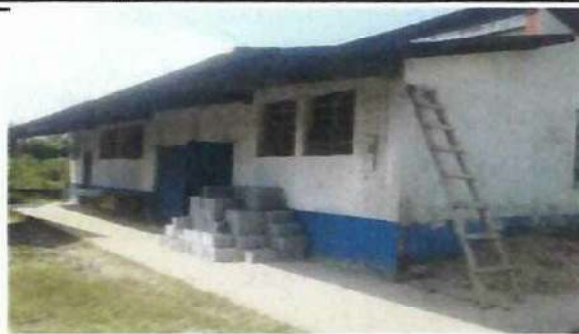
Foto 2: MODULO 2. cambio de laminas y costaneras
