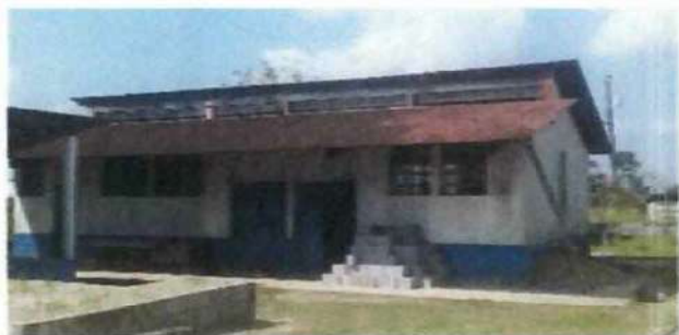
Foto 1: MODULO 1. Cambio de techo de un aula, dañado y oxidado.
