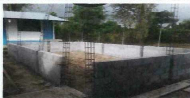
Foto 6: MODULO 6. Ampliación de cocina
