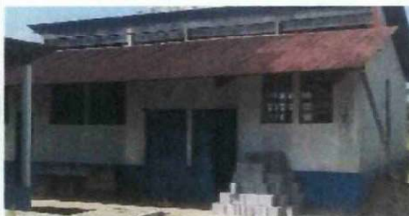
Foto 4: MODULO 4 Mantenimiento de puertas de aula
